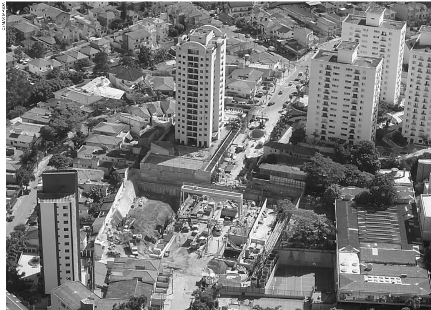
Estação Chácara Klabin, no novo trecho da Linha 2 do Metrô, deve funcionar em 2006
